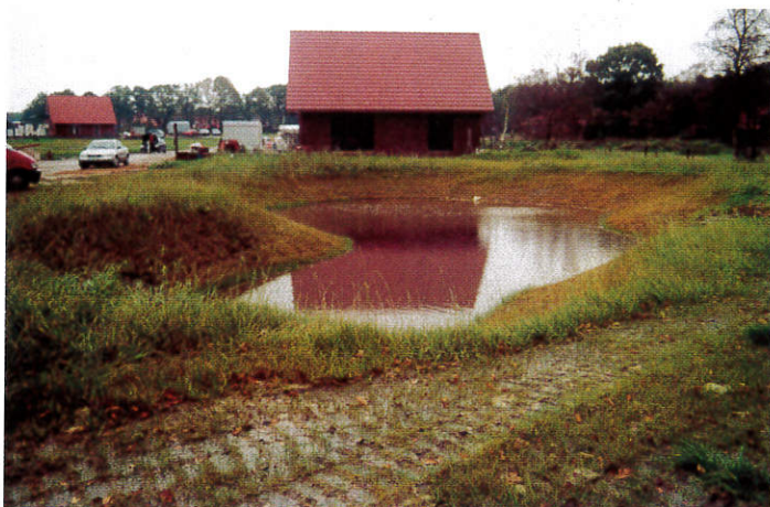
Das Regenrückhaltebecken verhindert, dass die Kanalisation überlastet wird.
