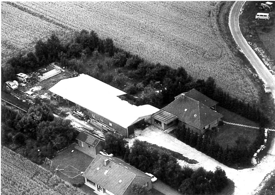
Wohnhaus und Lagerhalle des Bauunternehmers Menke Loers am „Alten Postweg“
